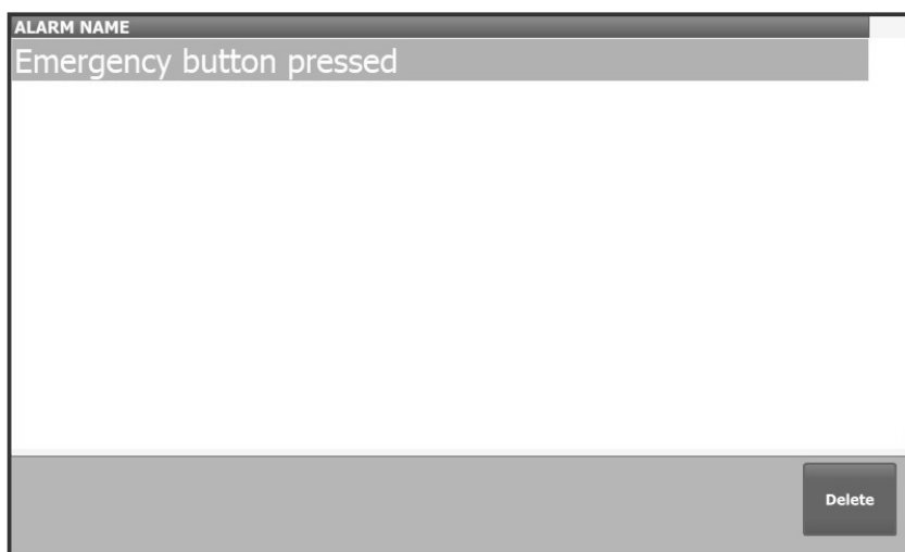
Aspectul panoului operatorului tunul de zăpadă - ecranul de defecțiune
